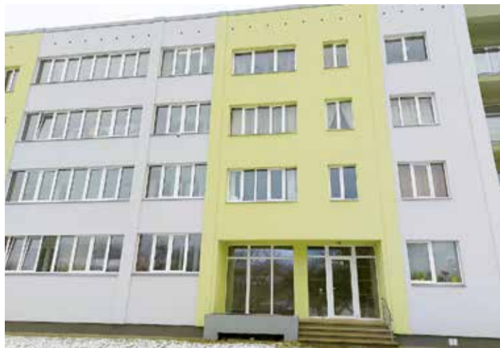
Renovēts nams Gaismas ielā 5.
