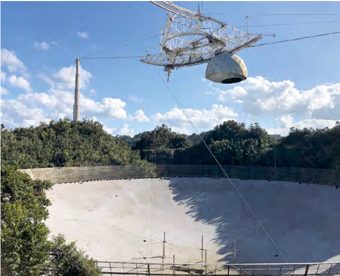
Aresibo radioteleskopa galvenais reflektors un trosēs iekārtā instrumentu platforma
