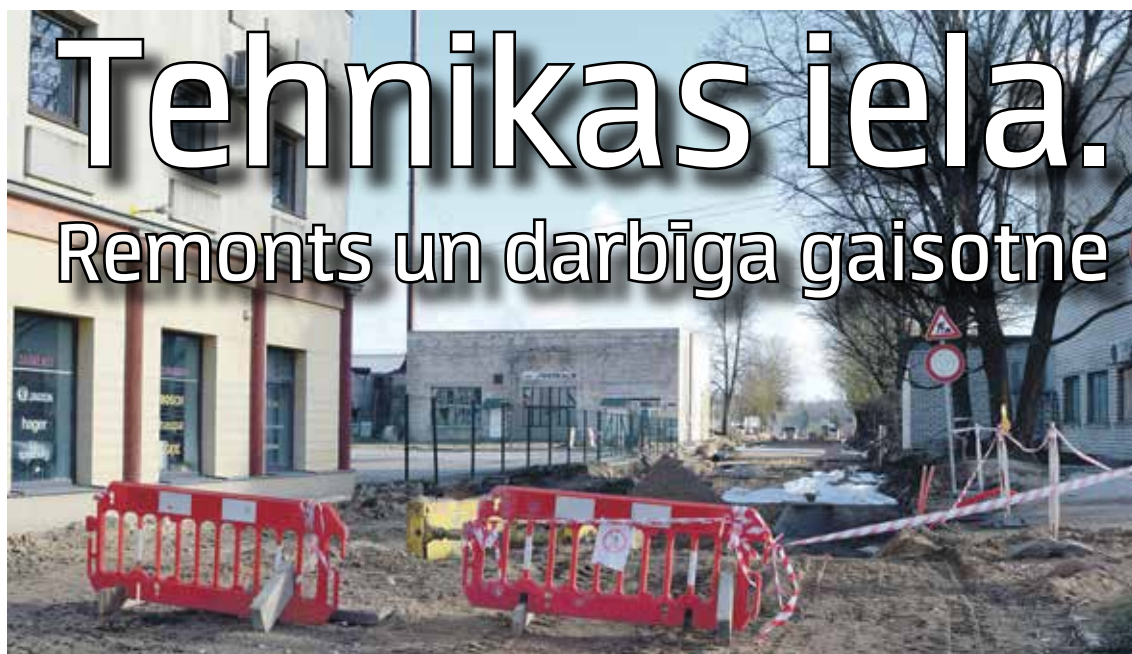
Tehnikas ielā tiek ierakts pazemes komunikācijas: ūdensvads, kanalizācija un lietusūdens sistēma.
