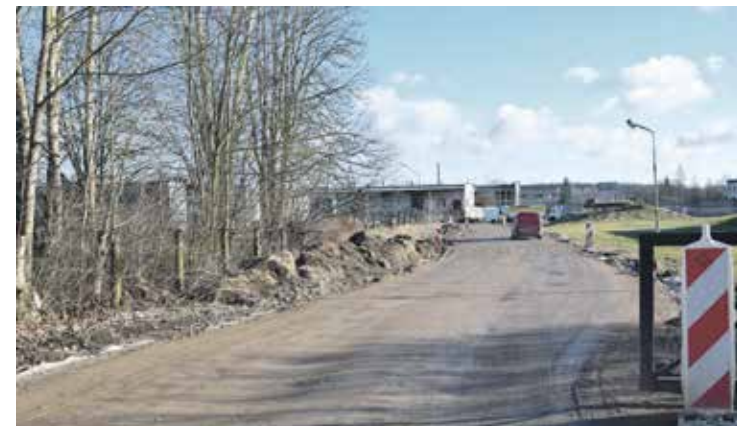
Lai varētu apbraukt remontējamo posmu, cauri teritorijai Tehnikas ielā 1 izveidota Gāzes iela.
