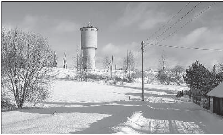
Водонапорная башня Пискуновка со стороны Лиелие Гаранчи.
