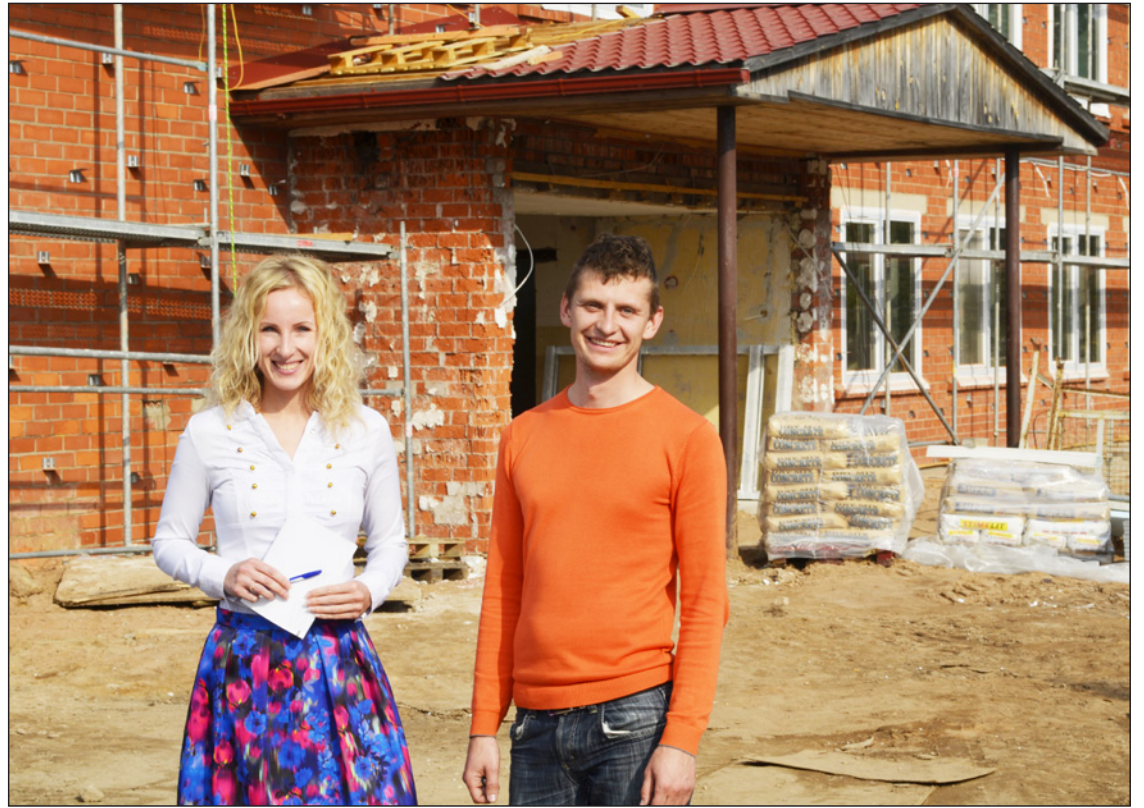
Veiksmīgi sadarbojoties būvdarbu vadītājam J.Keiselim (attēlā), projekta vadītājai S.Kašai (attēlā) un BPVV direktorei B.Vizulei, internāta renovācijas darbi raiti rit uz priekšu
