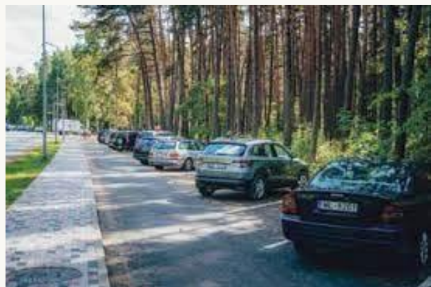
30. attēls. Pabeigti būvdarbi jaunu autostāvvietu un gājēju ietves izveidē Ainažu ielā.
