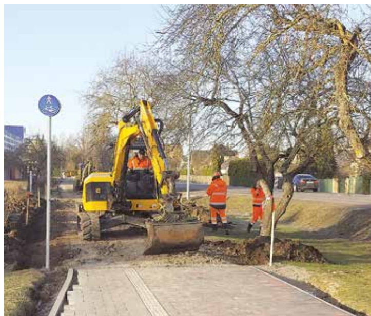
Gājēju celiņu pārbūve Rīgas ielā.
