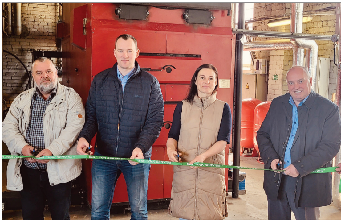
Jaunās šķeldas katlumājas iekārtas atklāj novada domes priekšsēdētāja pirmais vietnieks Guntis Mačtams, vietnieks Andis Zariņš, SIA "VNK serviss" valdes locekle Diāna Skudra un novada domes priekšsēdētājs Aivars Mucenīks. DIĀNAS SKUDRAS ARHĪVA FOTO
