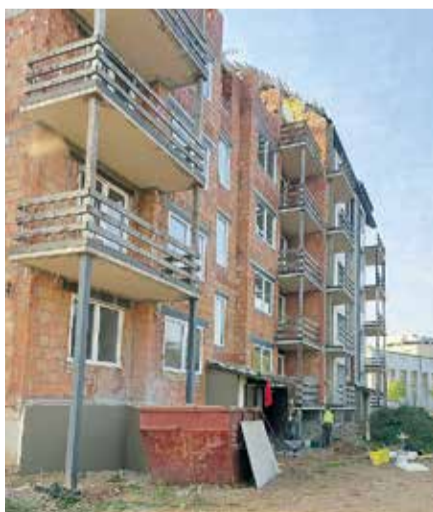
Šobrīd noris darbs pie jumta konstrukcijas izbūves un logu montāžas.
