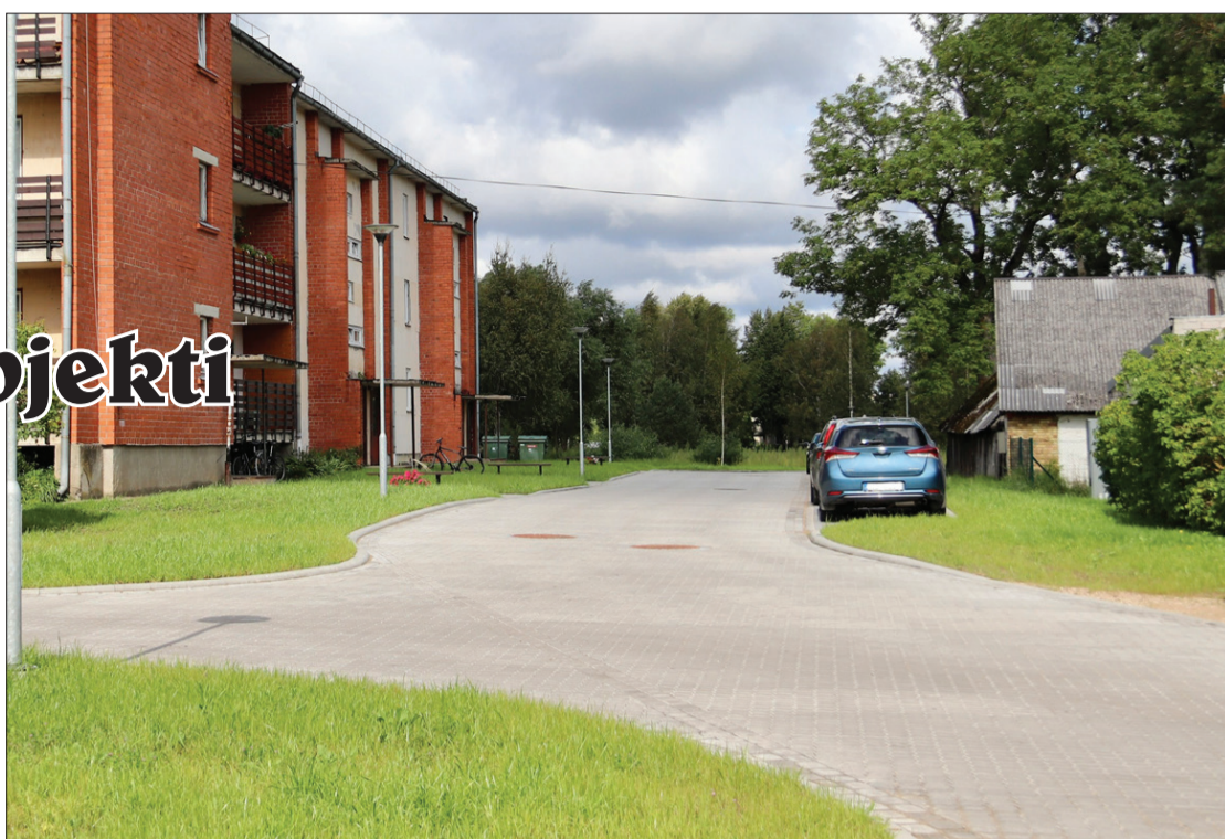
Lauku ielā rekonstruēts segums, izklājot to ar betona bruģakmeni.
