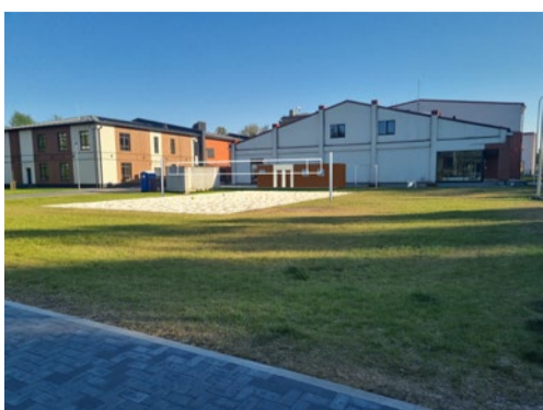
Pludmales volejbola laukuma, labierīcību, gērbtuvju un āra trenāžieru izveide Baložos, Skolas ielā 6.
