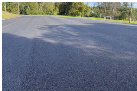
Zaķumuižas sporta laukuma pārbūve. Uzklāts porainā asfaltbetona segums.
