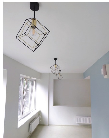
Mācību klašu pārbūve Upesleju sākumskolā. Objekts nodots ekspluatācijā.
