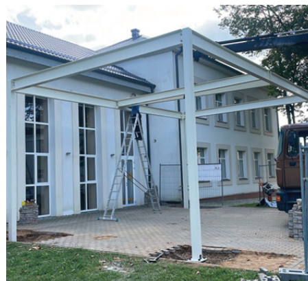
Vangažu Kultūras nama āra skatuves jumta būvniecība. Projekta īstenošanas termiņš 01.2024.
