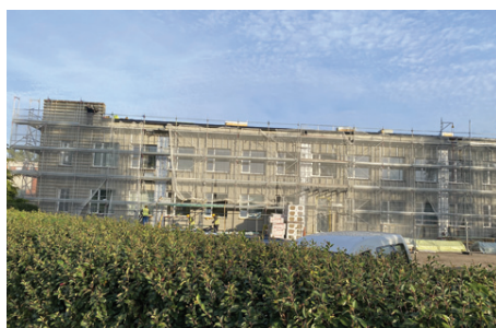
Ēkas Acones ielā 4 energoefektivitātes uzlabošana. Projekta īstenošanas termiņš 11.2023.
