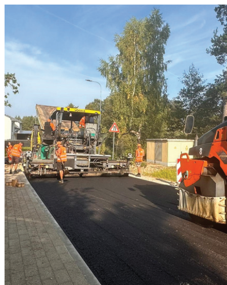
Mārtiņrožu ielas asfaltēšana Sunīšos. Pabeigti asfaltēšanas darbi.
