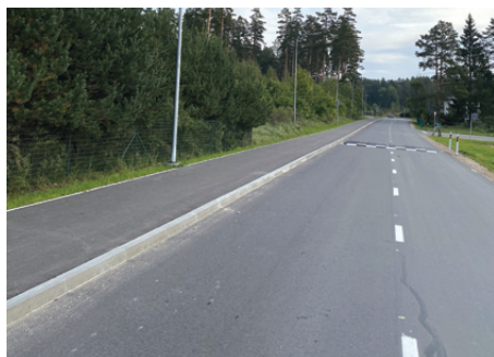
Ceļa C21 – Grīvas posma pārbūve. Objekts nodots ekspluatācijā.
