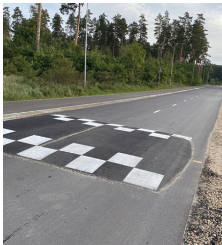
Ceļa ātrumvaļņu izbūve:
