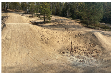
Velotrases “Kāpas” izbūve, Garkalnes pagasts. Darbi pabeigti. Notiek objekta nodošana ekspluatācijā.
