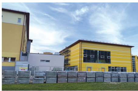
Ulbrokas vidusskolas piebūve, ugunsdzēsības rezervuāra un dziļurbuma izbūve. Projekta īstenošanas termiņš 12.2023.
