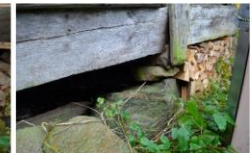
11 att. Ēkas austrumu malā izbūvēti stabiņveida pamati, ko veido viengabala laukakmeņi, vai to krāvējus bez saistvielām.
