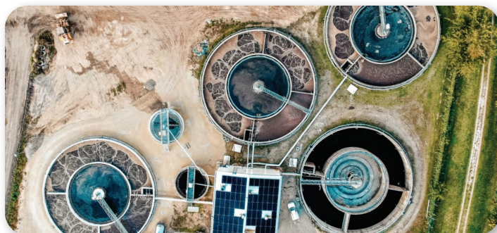
■ Ādažu notekūdeņu attīrīšanas iekārtu jaudas palielināšana - notekūdeņu attīrīšanas iekārtu rekonstrukcija.
