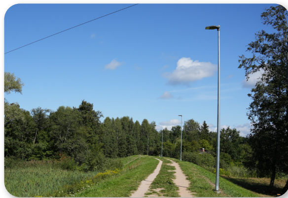
■ Izbūvēts apgaismojums gar gājēju ceļiņu Salas aizsargdambī.
