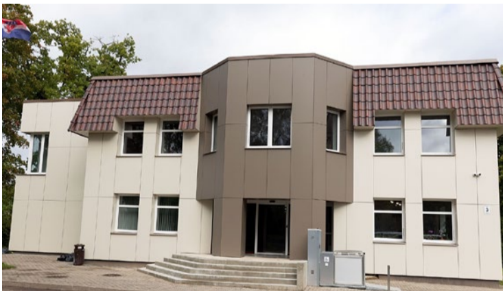
Uzlabota Baldones pilsētas pārvaldes ēkas energoefektivitāte.
