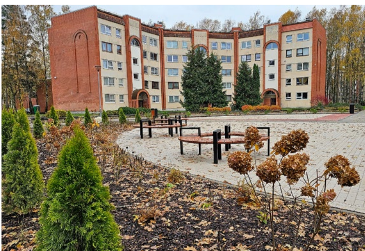
Iekšpagalma pārbūve aiz Baložu pārvaldes ēkas.
