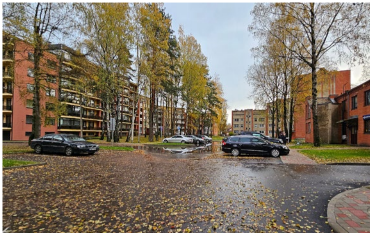
Teritorijas labiekārtošana un auto stāvlaukuma remonts Baložos, Zaļajā ielā 5.
