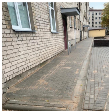
A. Pumpura iela 6 Talsos
