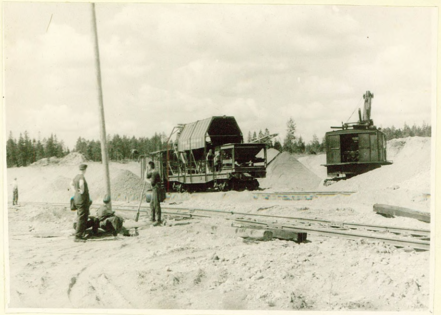
Smilts un grants materiāla mehānizēta ieguve un šķirošana Latvijas dzelzceļa Jaunkalsnavas karjerā
