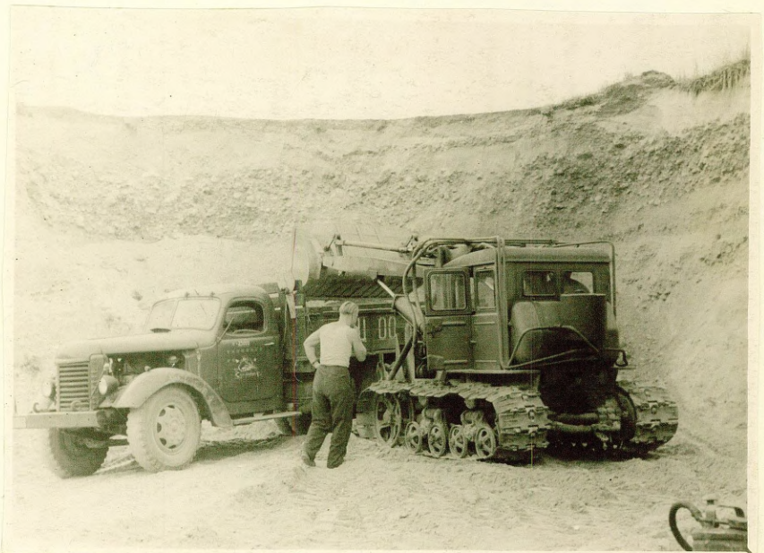
Karjers fluvioglaciālajā Odzes ezera - Jaunkalsnavas valnī. Grants mehānizēta ieguve Aiviekstes tilta būvdarbiem
