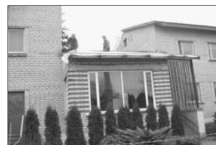
Apjomīgi remontdarbi notiek bērnu dārzā
