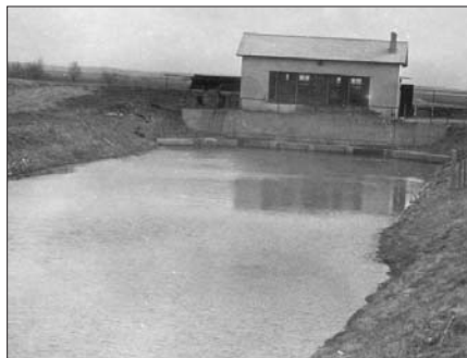
Rumbas poldera sūkņu stacija strādā kopš 1964.gada
