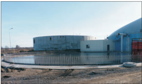
Viens fermentators ir gatavs, otrais – daļēji, bet trešajam – izbetonēti pamati.
