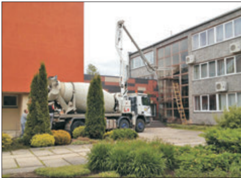
Tiek betonēta lifta šahta.
