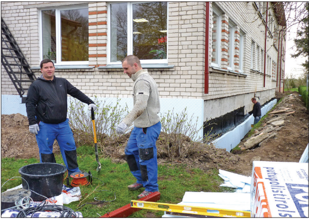
Uzsākta bērnudārza ēkas pamatu siltināšana.
