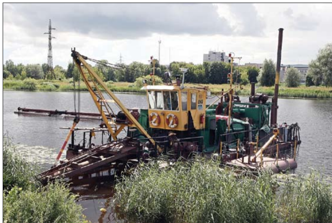
Lielupes labajā krastā darbi rit pilnā sparā un jau šonedēļ sāksies upes gultnes tīrīšana. To paredz projekts par aizsargdambja atjaunošanu posmā no dzelzceļa tilta līdz Rīgas ielai.
