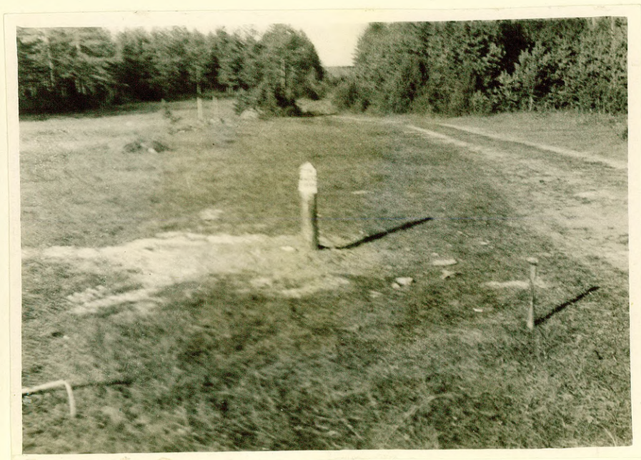
Фото №15. Скважина, закрепленная деревянным столбиком.
