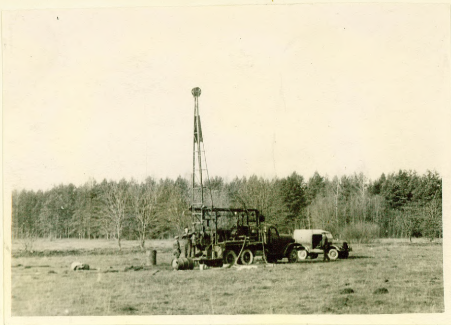
Фото №14. Бурение скважины станком С.Б.У. ЗУВ-150.
