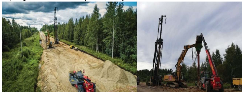
3.3. attēls. Kombinēto kolonnu un pāļu kolonnu būvniecība
