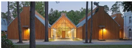
3.48. att. Ēku komplekss “Villa Marta” Bulduru prospektā 12, 14, 16, 18. 1996.– 2008. Meinhards fon Gerkāns, “Vincentis” [194].
