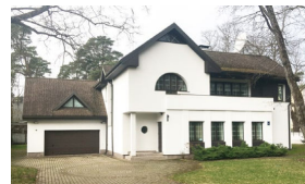
3.50 att. Vienģimenes dzīvojamā māja Ātrajā ielā 4. 1998. Ivars Strautmanis. Foto 2021.
