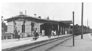
3.4. att. Dzelzceļa stacija Majoros [470].
