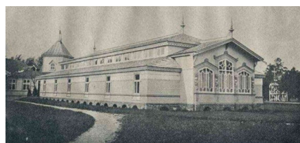
2.12. att. Vannu ēku vispārīgs tips, 1903 [40, 8].
