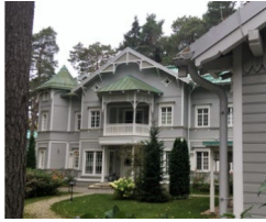
3.57. att. Vienģimenes dzīvojamā māja Ernesta Birznieka-Upīša ielā 21. Māris Pērkons. 2015. Foto 2022.
