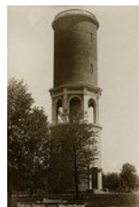
3.26 att. Çemeru ūdens tornis Tukuma ielā 32, 1929, F. Skujiņš [324].
