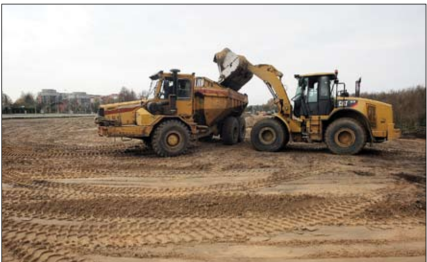
Lai gan šobrīd vecā BMX trase ir demontēta, jau nākamā gada vasarā te gozēsies pavisam jauna un moderna riteņbraucēju «arēna». Šoruden vēl tiks ierīkota drenāžas sistēma un uzbērtā pamatne, bet pavasarī trase iegūs savu formu.
