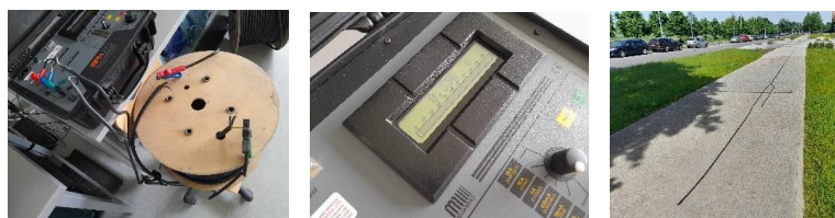
2.46. att. Kabeļu dzīslu pretestības mērīšana un kabeļu garumu salīdzināšana.
