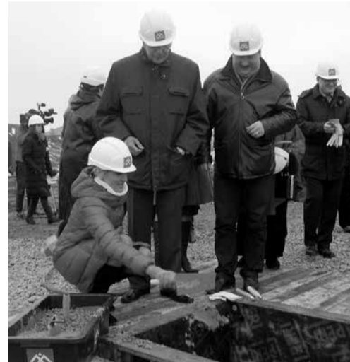
2012. gada 31. oktobrī Malda Caune kopā ar kolēģiem Mihailu Rogalu un Andreju Svilānu piedalījās jaunās halles pamatakmens iemūrēšanā. Šogad viņi jau atklās Salaspils sporta halli.
