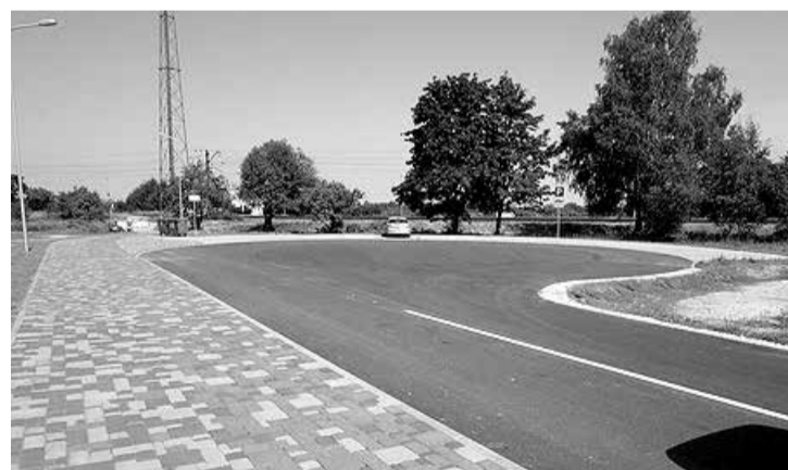
Kalnrozes ielā ir izbūvēta brauktuve, gājēju un velosipēdistu ceļiņš, izveidots stāvlaukums un uzstādīts apgaismojums.
