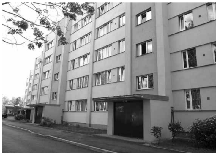
Pērn siltinātajām mājām ir pievienojies nams Enerģētiķu ielā 2, kura fasāde tagad rotājas gaiši oranžos toņos, un ēka ir kļuvusi siltāka kā jebkad.
