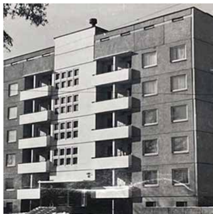
102. attēls. Tipveida projekta 119. sērijas piecstāvu eksperimentālā ēka Ilģuciemā, V. Tereškovas (tagad Buļļu) ielā (20. gadsimta 70. gadi).
