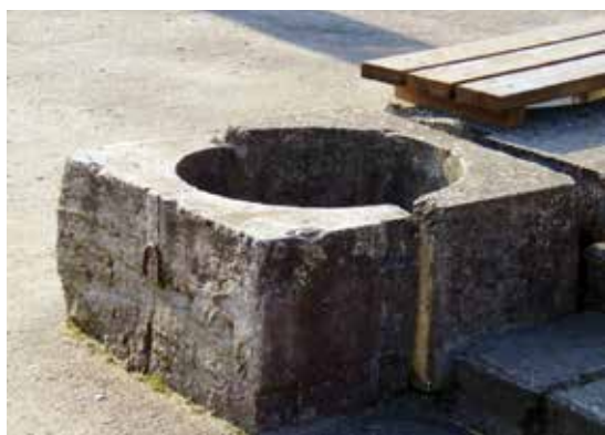
109. attēls. Saliekamo dzelzsbetona konstrukciju atkritumu urnas Ķīpsalā (2008).
