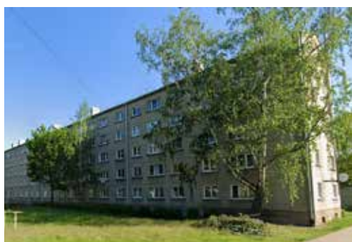
38. attēls. Tipveida projekta 1-430. sērijas piecstāvu dzīvojamā ēka Rīgā, Patversmes ielā 30 ( GoogleMaps ).
