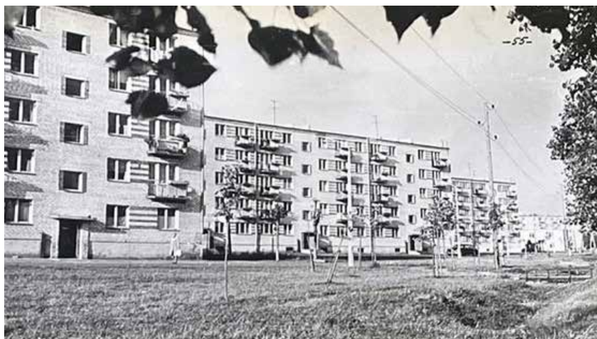
53. attēls. 1-316. sērijas ēkas Kauguros (20. gadsimta 60. gadu beigas). Galvenais arhitekts A. Reinfelds.
