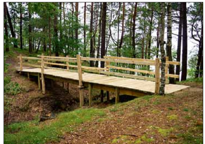
Rekonstruētais tiltiņš Bērzu ielas izejā uz jūru.
