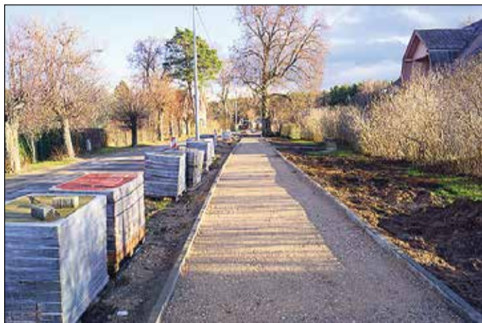
A. Kalniņa ielā notiek ietves rekonstrukcija.
