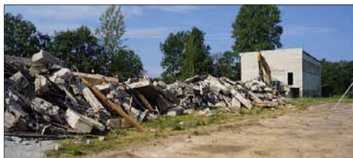
Zvejniekciema stadiona veco tribīņu demontāža. Foto autors: Normunds Līcis
