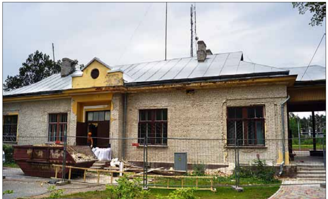
Rekonstrukcijas laikā tiks atjaunota vēsturiskās stacijas fasāde, renovēta uzgaidāmā zāle, kā arī izbūvētas jaunas labierīcības. Foto no domes arhīva
