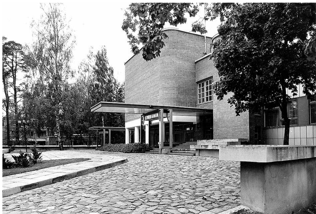
Imanta Jēkabsona, Dzintara Dribas un Rūsiņa Riņķa projektētā Saulkrastu novada domes ēka.
