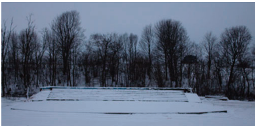
Neretas brīvdabas estrāde šī gada janvāra sākumā rekonstrukcijas procesā
