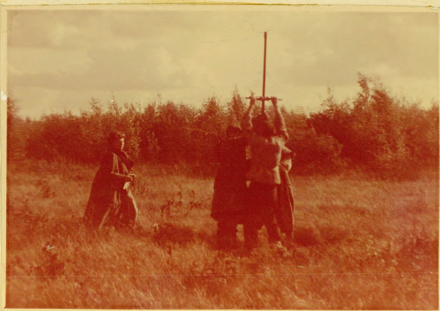
Фото 2. Зондировочное бурение в точке 2004 /кв 80-00/
