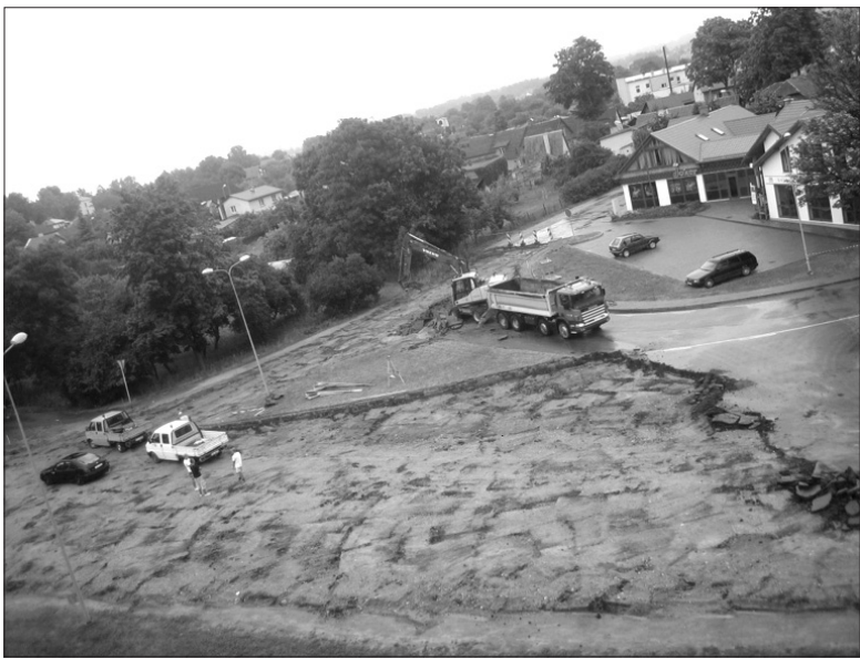
Rekonstrukcijas darbu sākums š. g. 11. jūlijā Dundagas un Lielgabalu ielu krustojumā.
