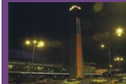
Rīgas Centrālās dzelzceļa stacijas pulksteņa tornis ar daudzprogrammu sinhronu gaismas sistēmu / Riga Central Railway station clock tower with multi-programme synchronous lighting system. 1980.
