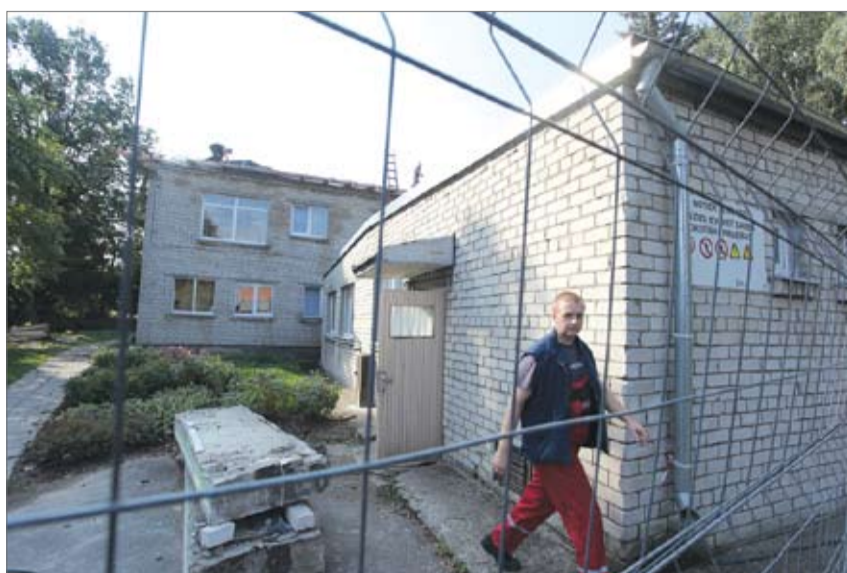
Pašlaik bērnudārzā «Zemenīte» norit jumta rekonstrukcijas 1. kārtā – virs grupiņu telpām tiek izbūvēts divslīpņu jumts. Saskaņā ar līgumu darbiem jābūt pabeigtiem 20. septembrī, taču savas korekcijas var ieviest laika apstākļi. Foto: Ivars Veiliņš
