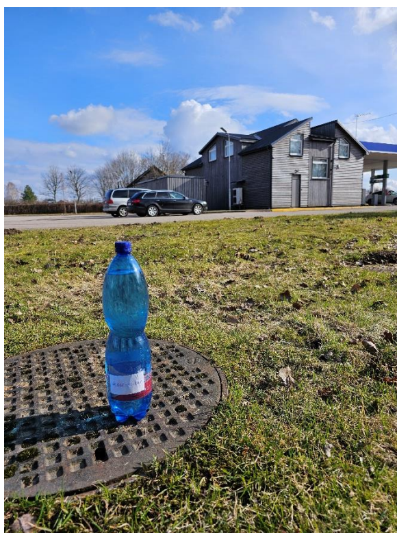
3. attēls. Skats uz sadzīves notekūdeņu attīrīšanas iekārtas aku un paraugu noņemšanas vietu (25.03.2024.)
