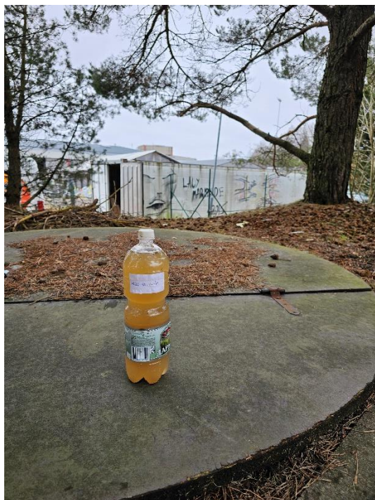
2.attēls. Skats uz sadzīves notekūdeņu attīrīšanas iekārtas ieplūdes aku un ieplūstošā sadzīves notekūdeņu paraugu ņemšanas vietu (19.03.2024.)
