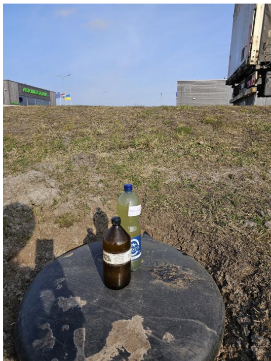
4.attēls. Skats uz sadzīves notekūdeņu attīrīšanas iekārtas ieplūdes aku un ieplūstošā sadzīves notekūdeņu paraugu ņemšanas vietu (14.03.2024.)
