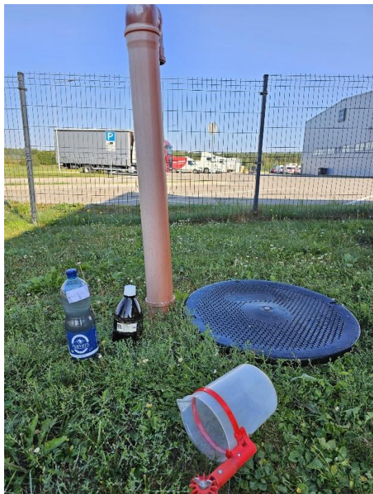
5.attēls. Skats uz ražošanas notekūdeņu attīrīšanas iekārtas ieplūdes aku un ieplūstošā ražošanas notekūdeņu paraugu ņemšanas vietu (27.08.2024.)
