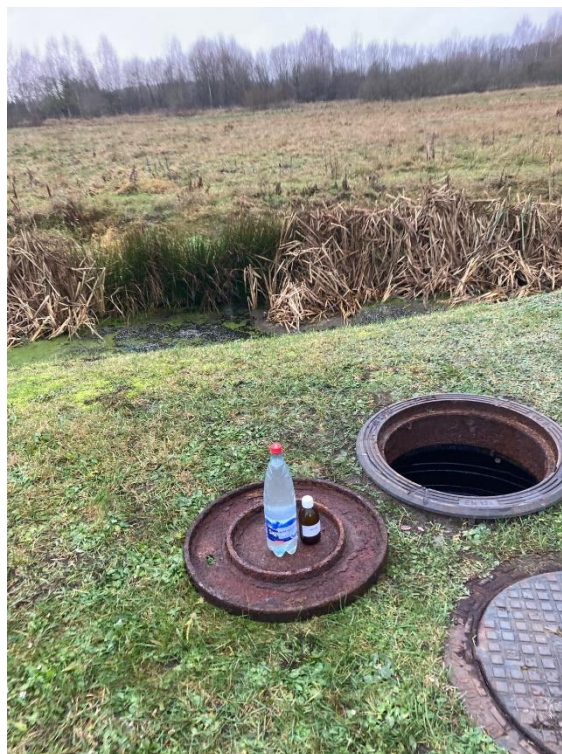
4. attēls. Skats uz aku, kurā izplūst NAI attīrītie sadzīves, un izplūstošo notekūdeņu paraugu ņemšanas vietu(28.11.2024.)
