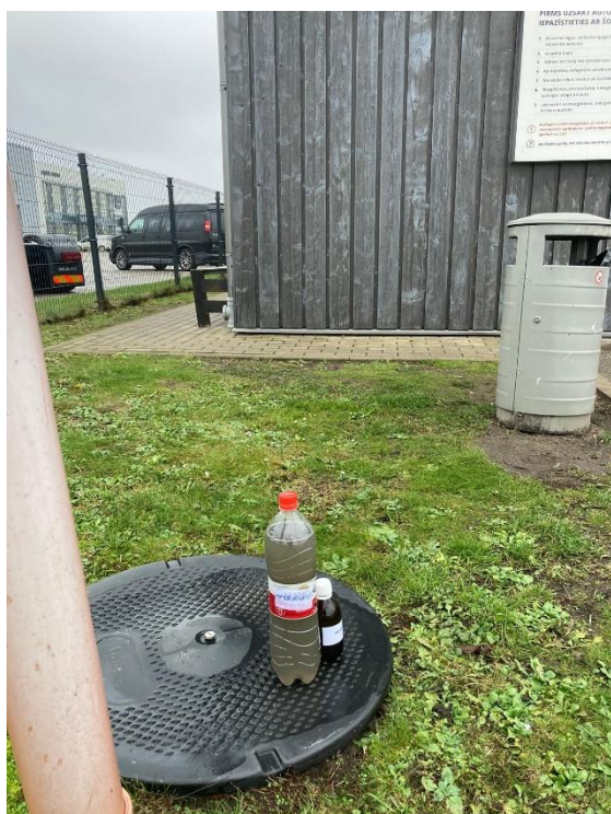
5.attēls. Skats uz ražošanas notekūdeņu attīrīšanas iekārtas ieplūdes aku un ieplūstošā ražošanas notekūdeņu paraugu ņemšanas vietu (28.11.2024.)
