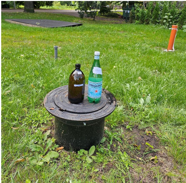
2.attēls. Paraugu ņemšana no pēdējās skatākas lietus notekūdens attīrīšanas iekārtas sistēmā pirms infiltrācijas laukiem (01.08.2024.)
