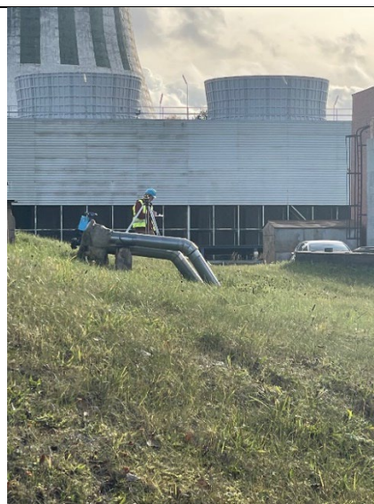
12.Foto. Gruntsūdens pagaidu novērošanas akas Nr.5 augstuma piesaiste izmantojot nivelieri.
