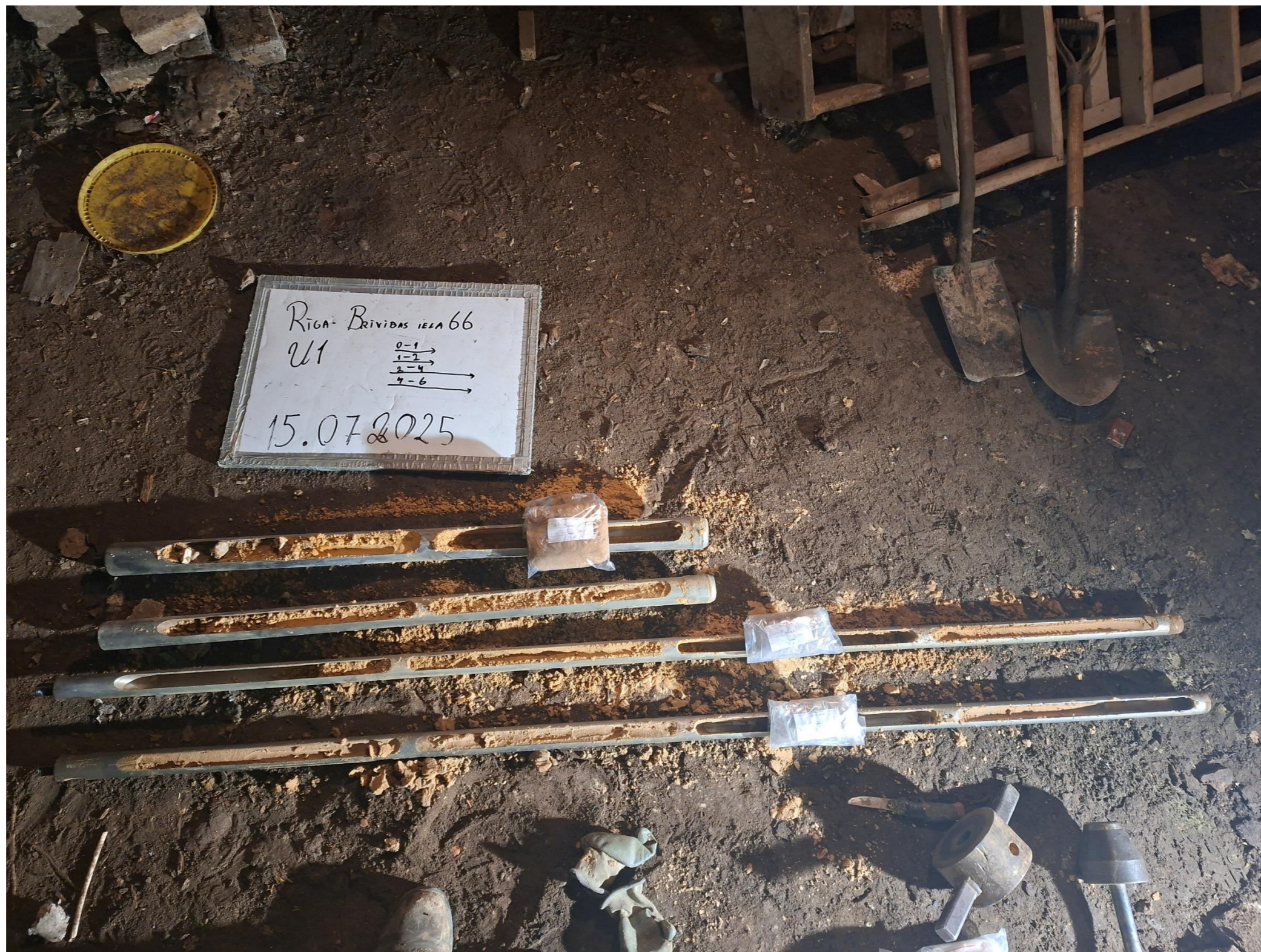
2. Attēls. Ģeotehniskās izpētes darbi Brīvības ielā 66, Rīgā, 2025. gada 15. jūlijā.
