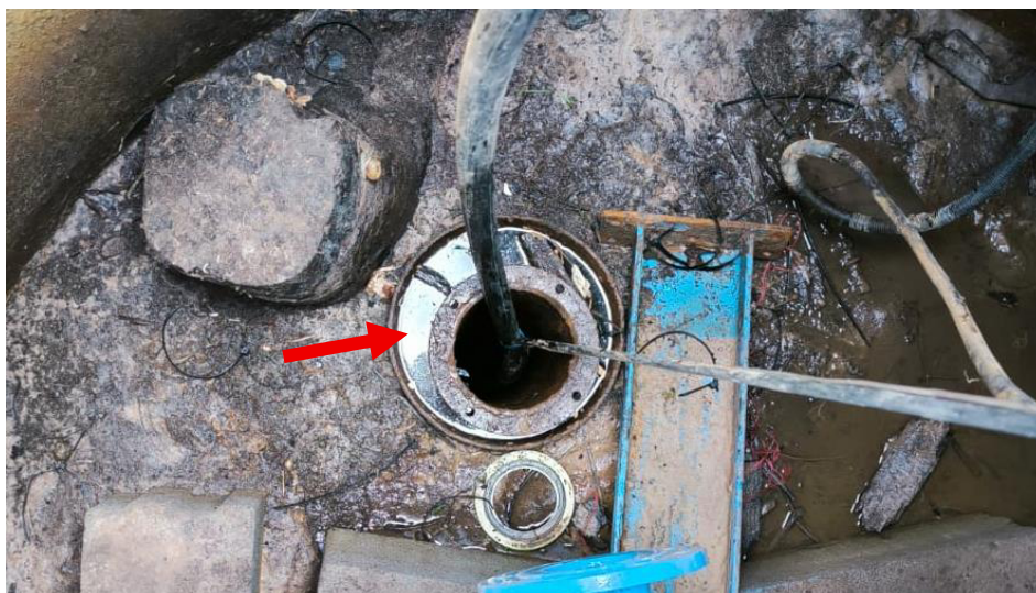
1. attēls. Urbuma augšējā caurule šūpojas konduktorā.
